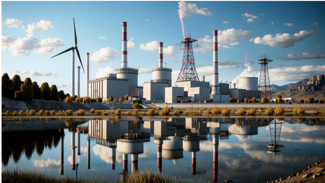
Рис. 1. Внешний вид современной электростанции
