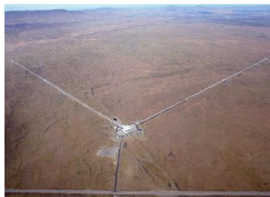
Фото 6. Установка ЛИГВО из Хенсфорда
