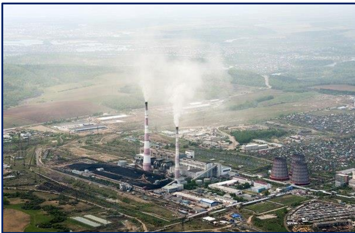
Рисунок 11. Новокузнецкая тепловая электростанция
