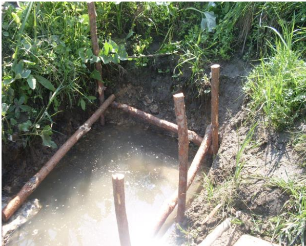
Рис.9.Огораживание забором места выхода воды
