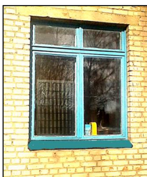
Фото 2. Использование дачного коллектора в школе
